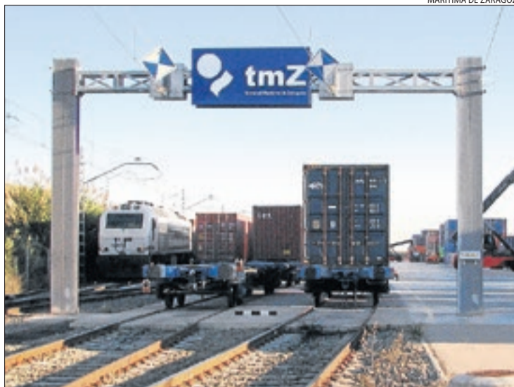
Imagen de las instalaciones de la terminal Marítima de Zaragoza
