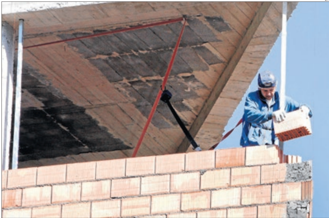
Imagen de un trabajador en la construcción de un bloque de viviendas.
