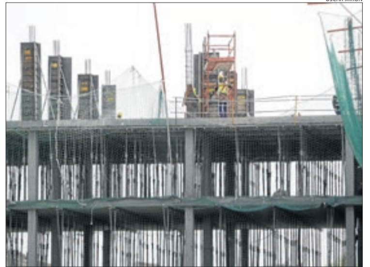
Trabajos de construcción de un edificio en Lleida.
