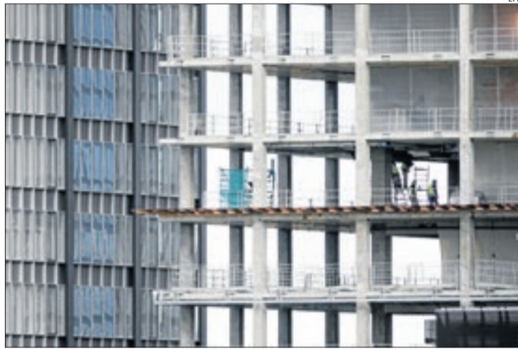
Imagen de un edificio en construcción.
